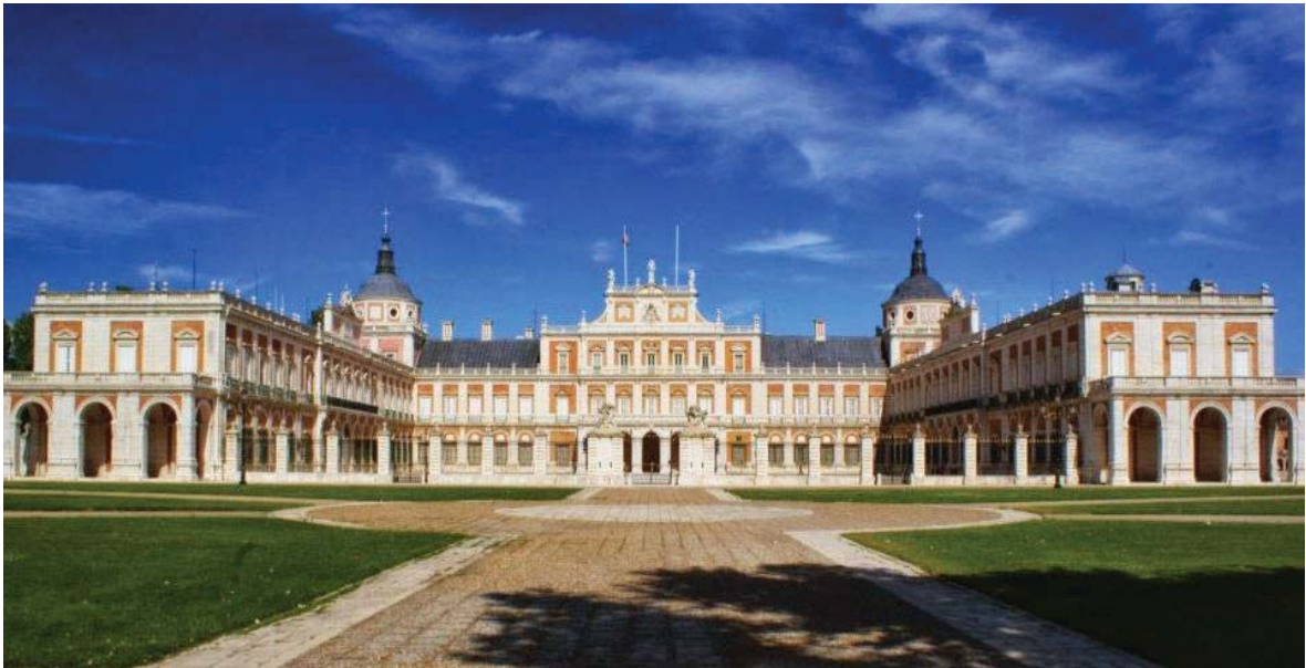
Fig. 8 Fachada principal del Palacio Real de Aranjuez Fuente: arquites.wordpress.com/es
