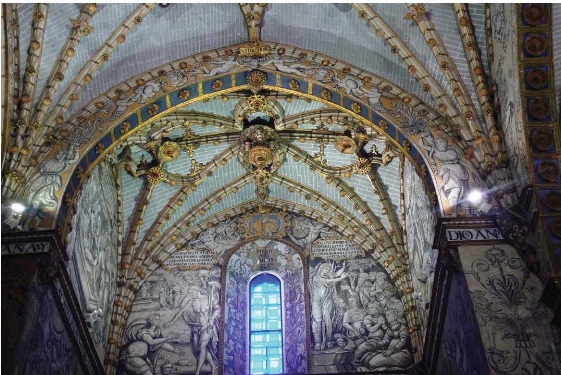
Bóveda de la capilla derecha del crucero y grisalla
