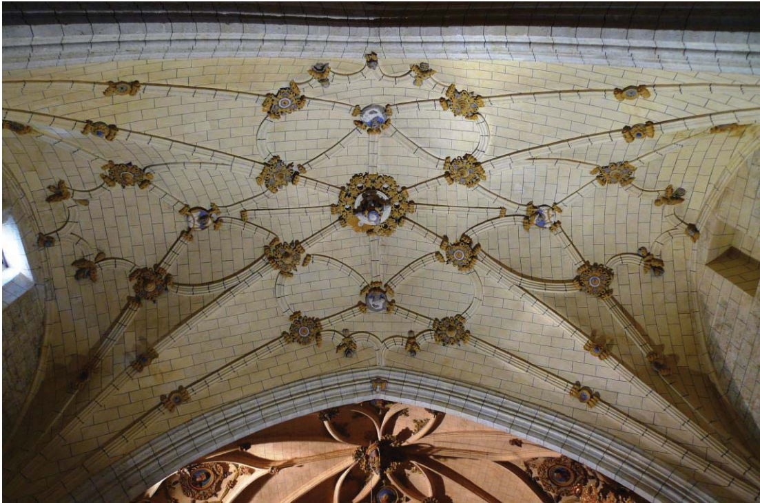
Vista de la bóveda contigua al coro.
