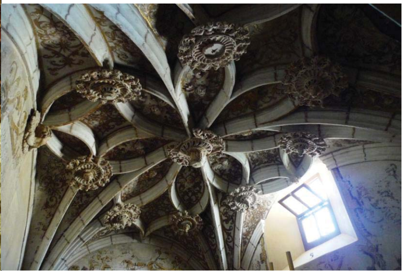
Bóveda de la sacristía.
