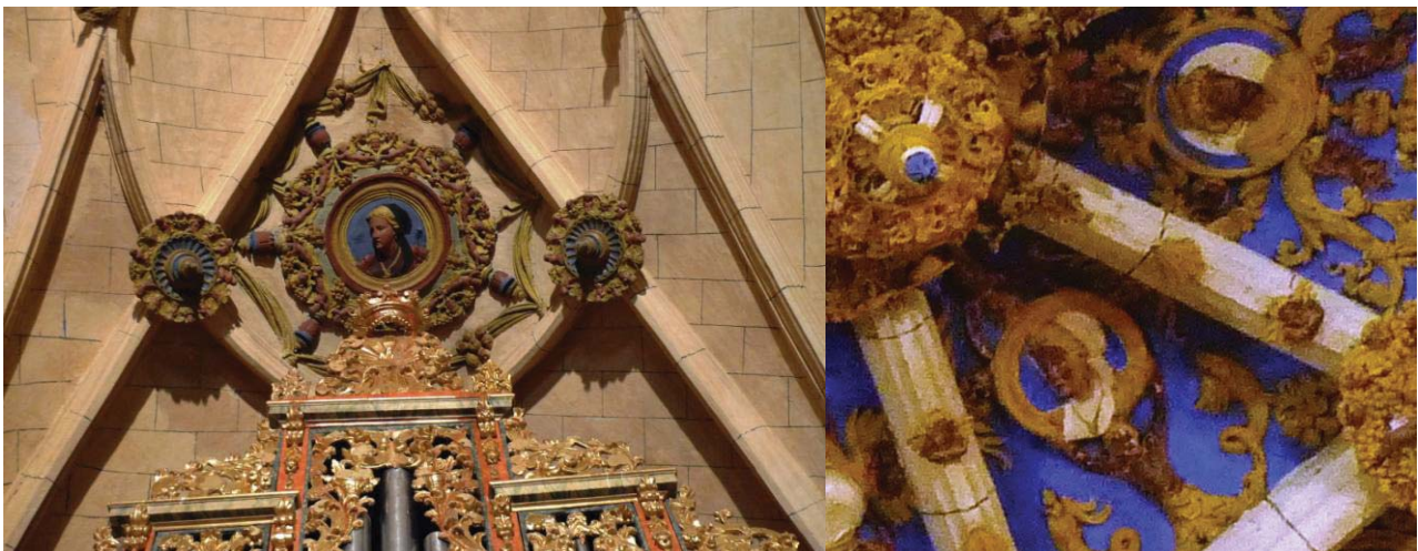
Medallón femenino situado encima del órgano del coro. Se repite en la plementería de la bóveda de la Capilla Mayor.
