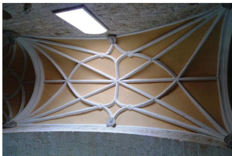
Vista bóveda central en la que se aprecian medallones en los arranques de los nervios.
