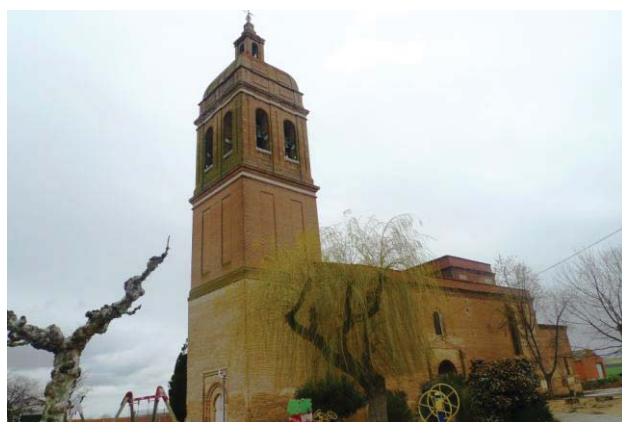
( Fig 50 ) Vista del exterior.
