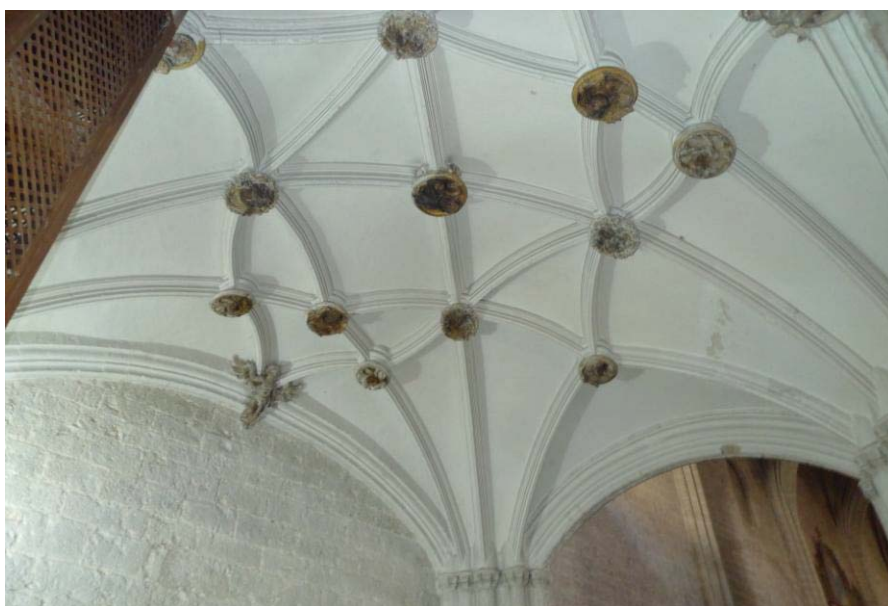
( Fig 63 ) Vista de la bóveda.
