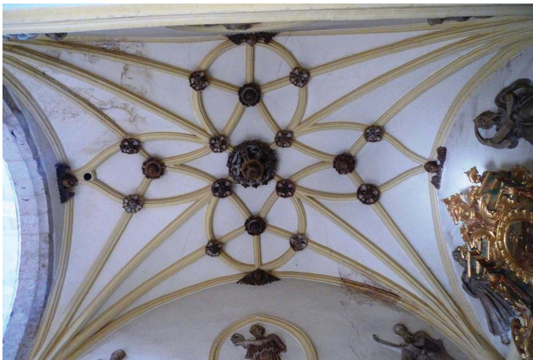
( Fig 21) Vista de la bóveda de crucería, claves y pinjantes.
