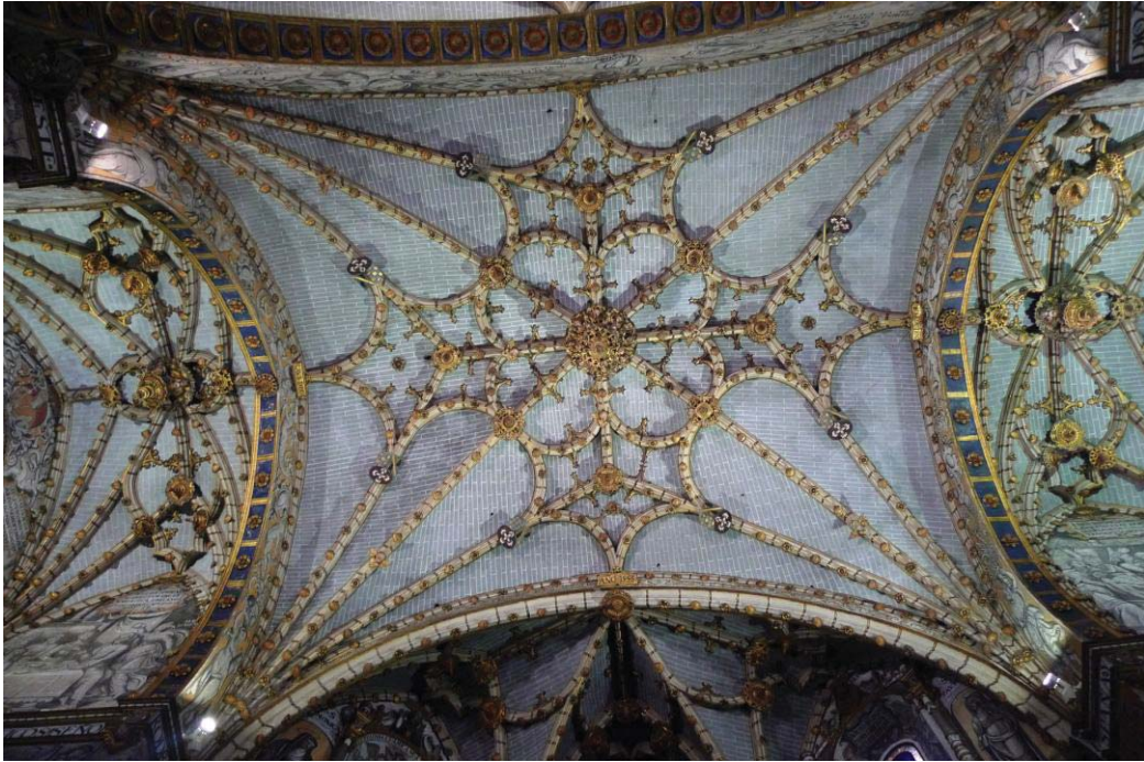
(Fig 60) Bóveda del crucero y vista de las rosetas que adornan el casetón en el intradós de los arcos.
