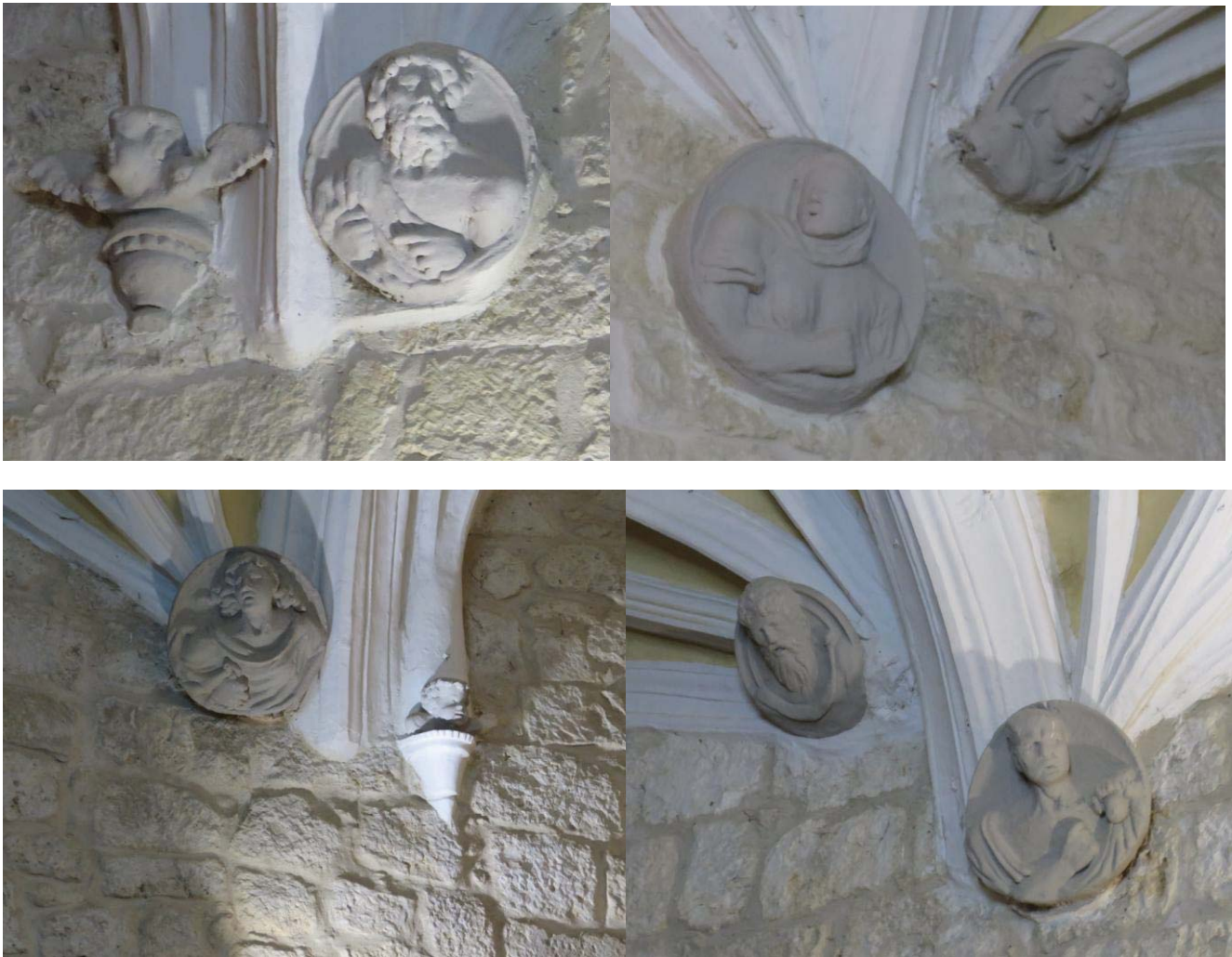
(Fig 72) En los arranques de los nervios quedan al descubierto 24 grandes medallones realizados en yeso, con bustos que se asemejan a personajes de la época romana y ya vistos en el catálogo de sus obra.
