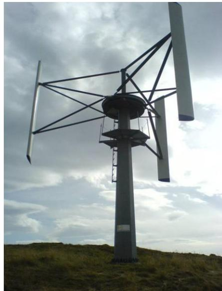
*Imagen 2.1 Aerogenerador H-Darrieus*
