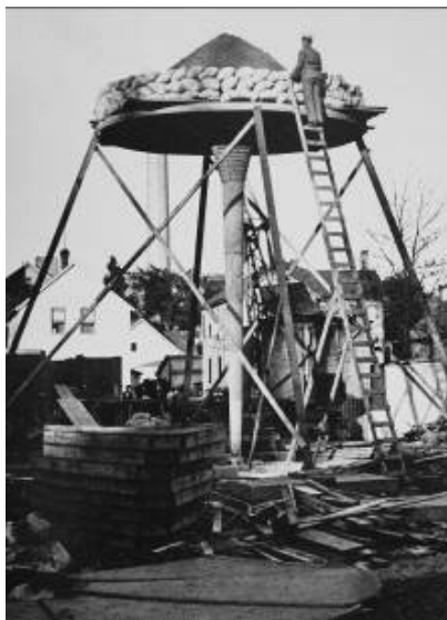
Figura 37. Imagen de la realización de la prueba de carga
