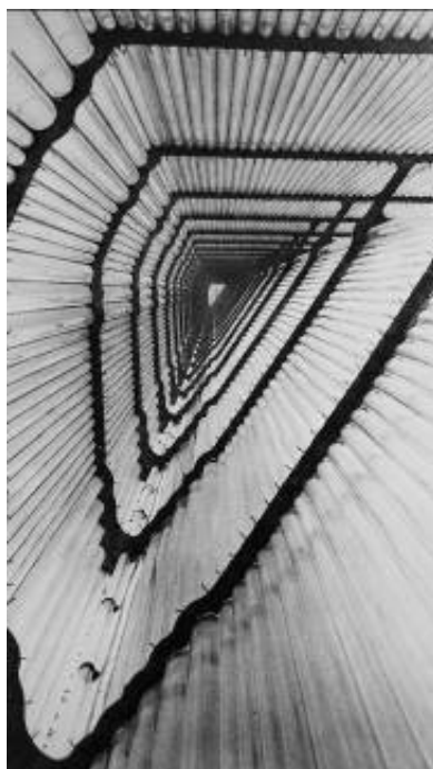
Figura 41. Imagen interior del detalle final de la claraboya con la introducción de la luz artificial.
