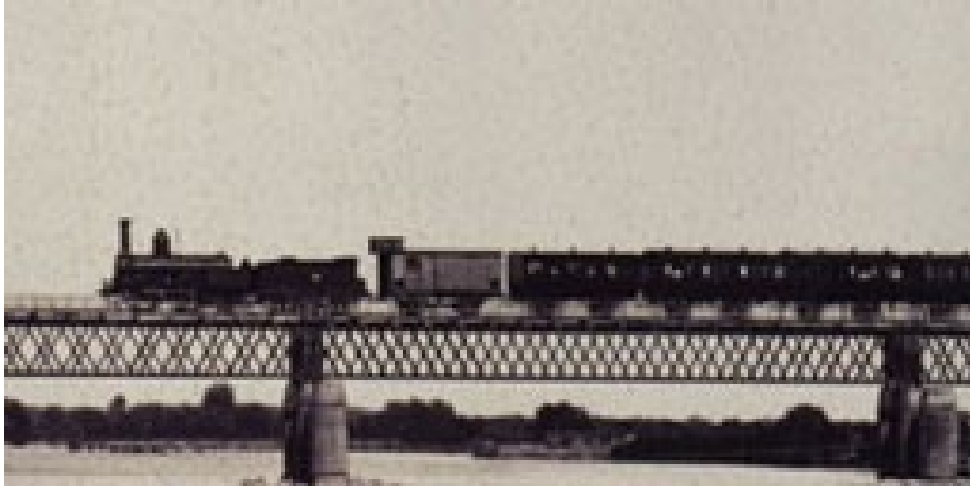
Figura 2. Puente ferrocarril sobre río Ebro
