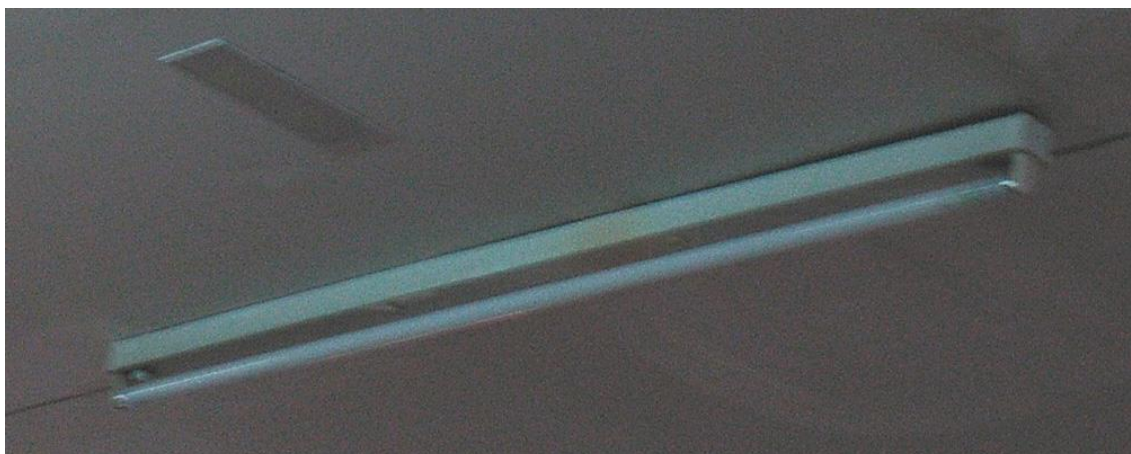
Figura 52. Luminaria con una lámpara fluorescente Lumilux T8 58W/840 OSRAM. Fuente: Elaboración propia
