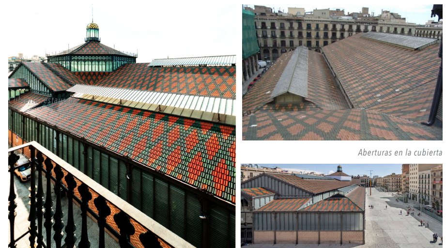
Cubierta restaurada con las mismas aberturas que la antigua
