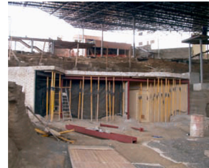
Apuntalamiento para la construcción del pórtico
