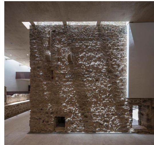
Vista interior con los lucernarios en el encuentro del forjado con el torreón
