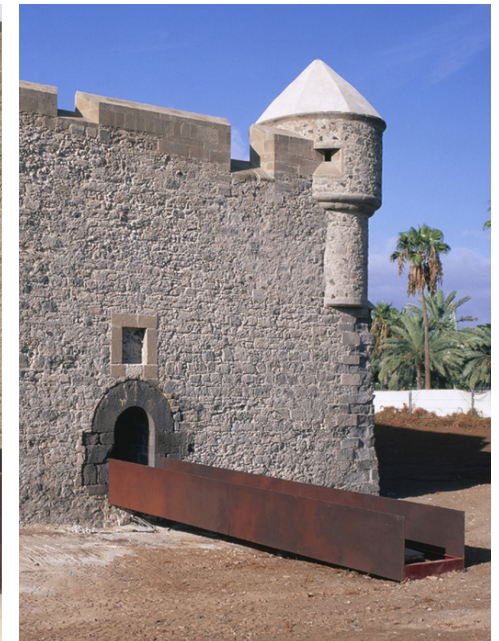
Vista exterior del nuevo Castillo de la Luz
