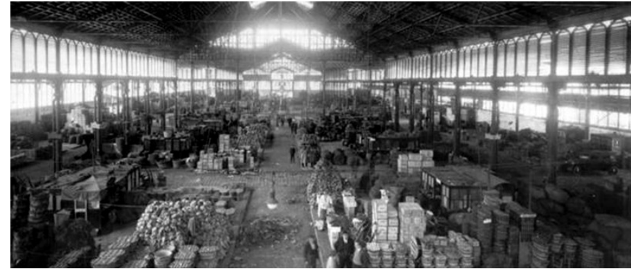
Interior de la primera construcción del Mercado del Born
