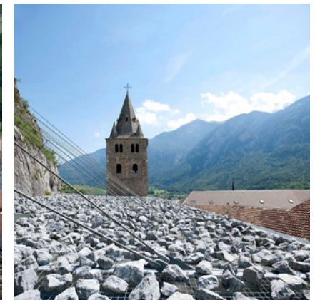
Vista superior de la cubierta
