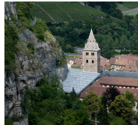
Vista aérea de la cubierta
