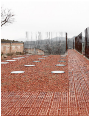
Terraza superior con pavimento poroso y drenante
