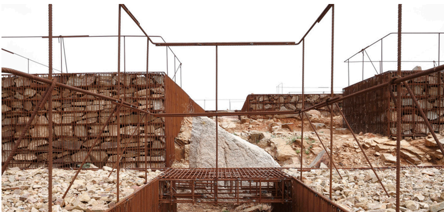
Vista de la disposición de armaduras para contener los muros
