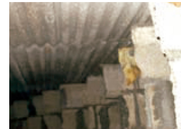
Cámara entre el primer y segundo forjado del antiguo cierre de la cubierta
