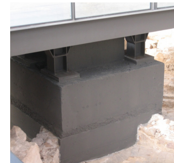
Pilones de hormigón
