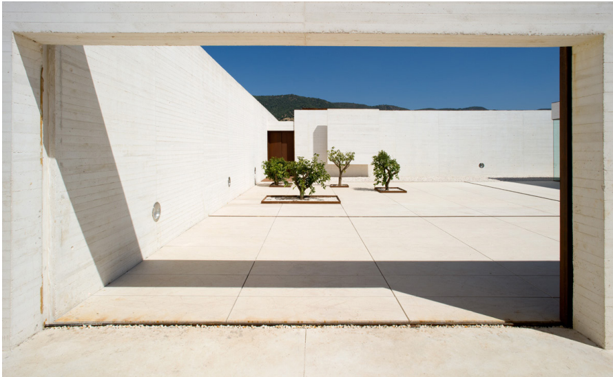
Vista desde el exterior hacia el patio
