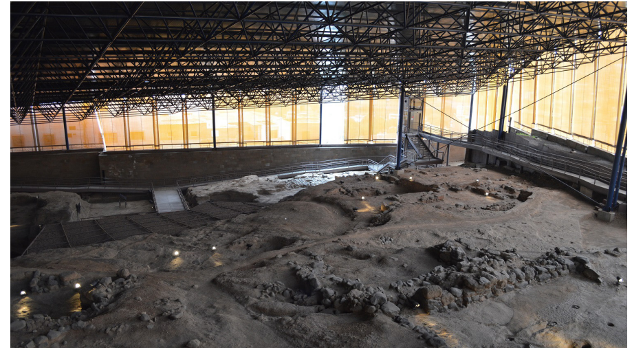
Vista interior donde se observan los cerramientos y la disposición de los escasos pilares
