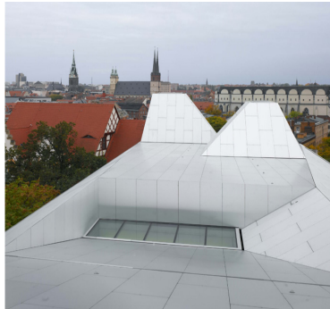
Lucernarios en la cubierta
