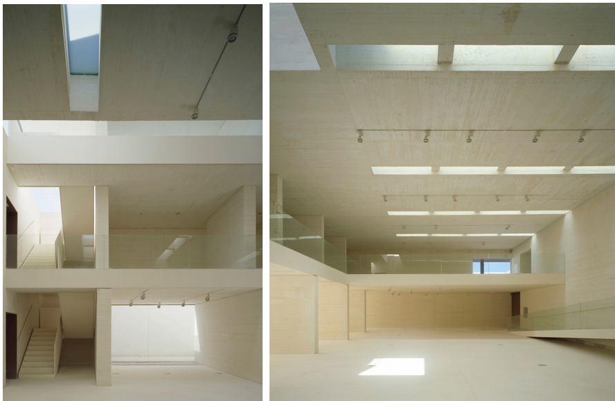
Espacios interiores, Talleres con lucernarios longitudinales y entreplantas
