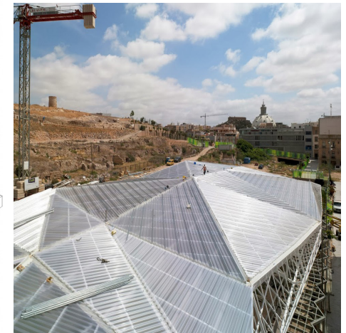
Fase de construcción
