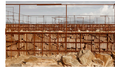
Vista de la disposición de armaduras para contener los muros
