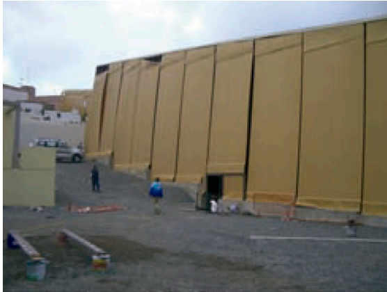
Cerramientos exteriores vistos desde la calle
