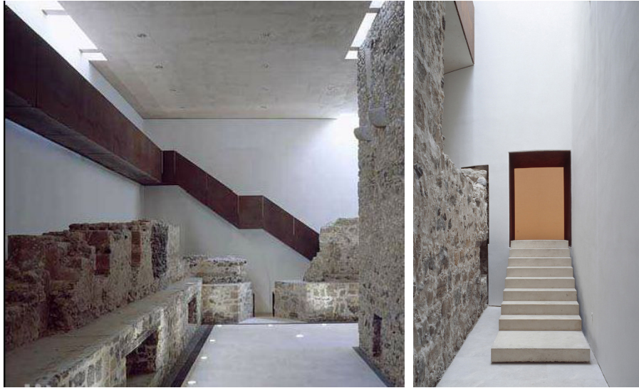
Vistas interiores donde se ve la integración de los antiguos muros del castillo con los nuevos de la rehabilitación
