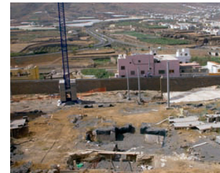
Grúa y pilares dispuestos sobre encepados
