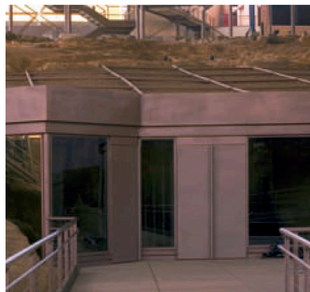
Cerramiento de la cueva pintada acabada
