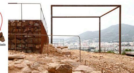
Vista exterior de la reconstrucción con armaduras
