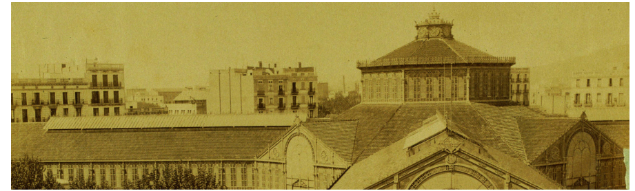
Cubierta del antiguo Mercado
