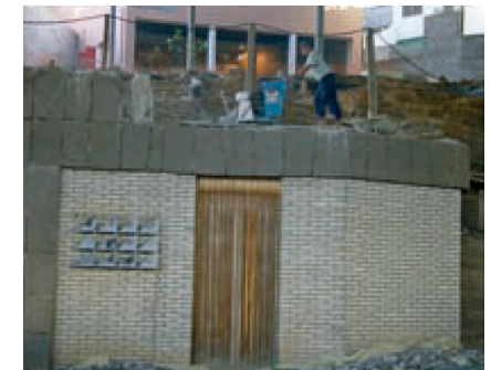
Proceso de demolición del forjado superior
