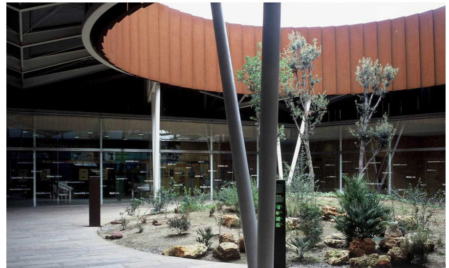
Exterior del conjunto, patio abierto con vegetación
