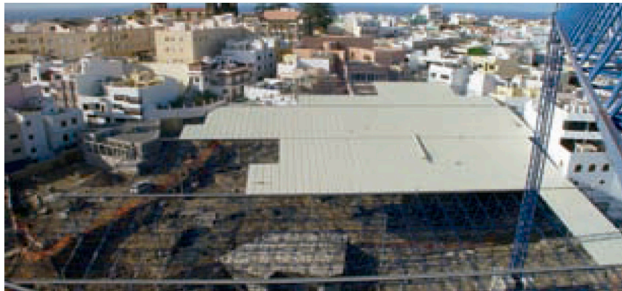
Colocación de los paneles sandwich sobre la cubierta
