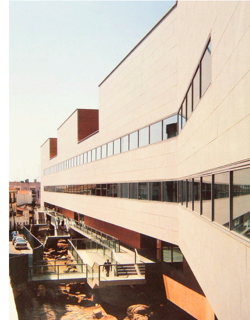
Vista de las escaleras y rampas de acceso al edificio
