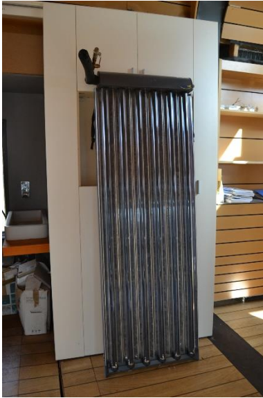
Imagen 15. Panel solar térmico de aire en el interior de la Casa Solar.
