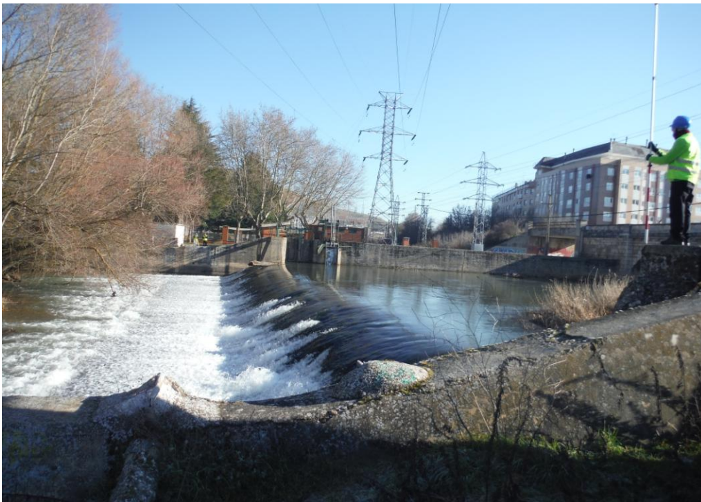
Ilustración 15: Vista del azud desde el margen izquierdo
