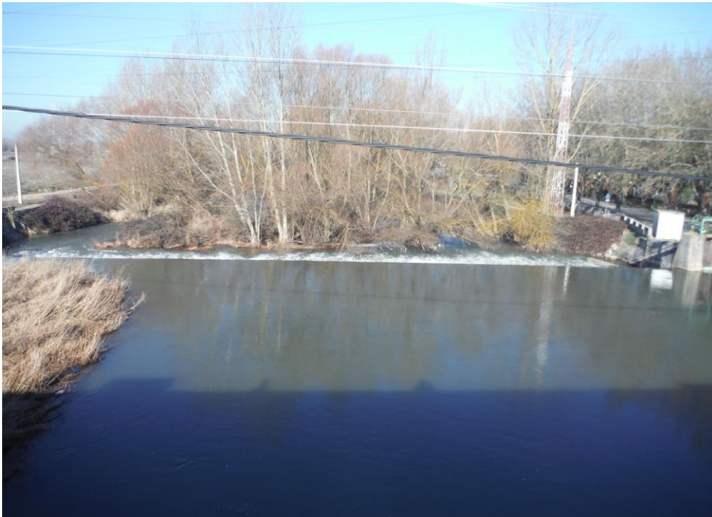
Ilustración 14: Azud visto aguas arriba
