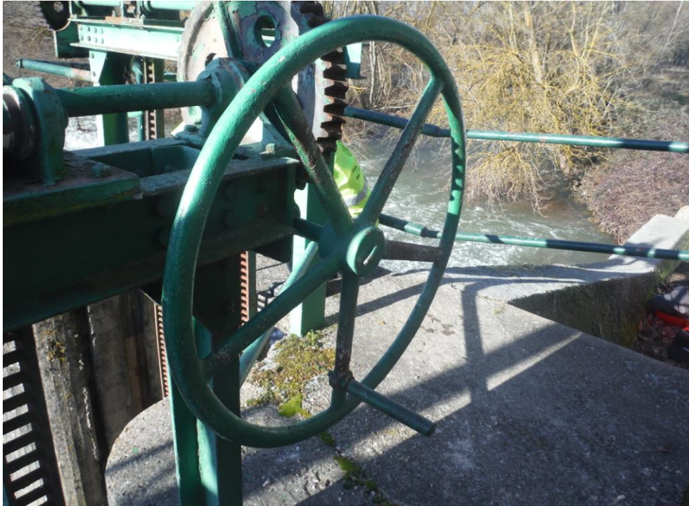
Ilustración 13: Detalle accionamiento de la compuerta
