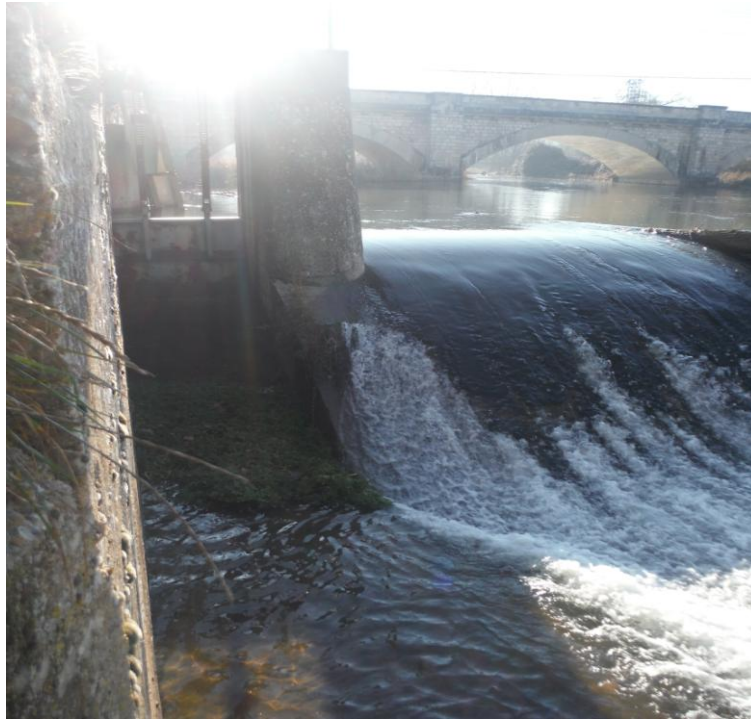
Ilustración 11: Detalle compuerta del margen derecho
