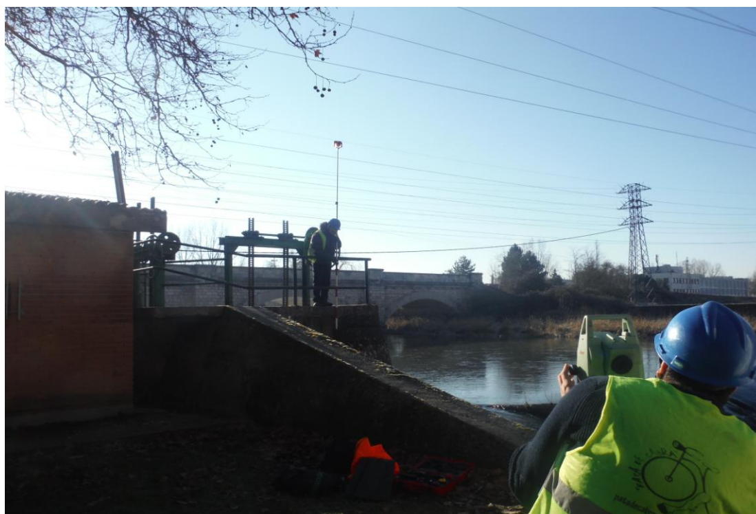
Ilustración 10: Toma de datos del perfil del azud
