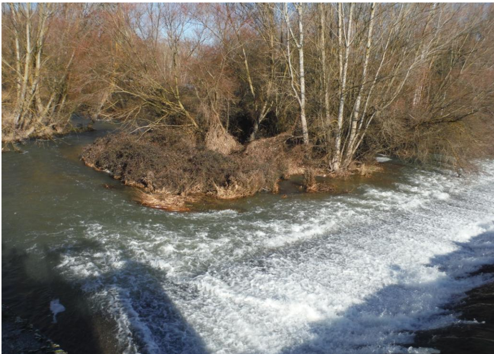
Ilustración 18: Vista del azud aguas abajo
