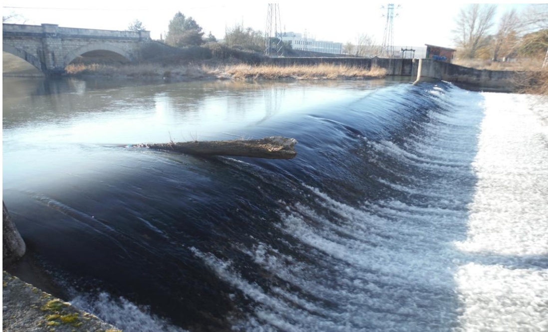
Ilustración 07. Azud del puente del Ferrocarril
