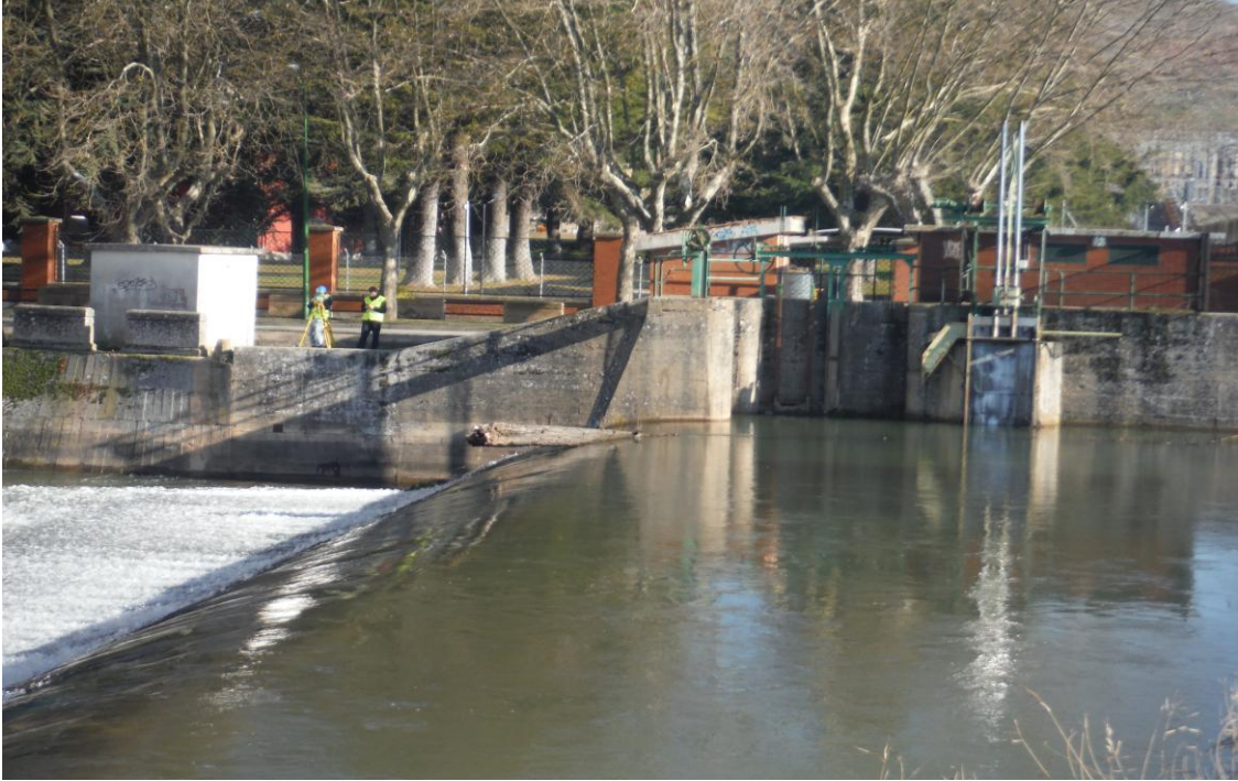
Ilustración 19: Vista del perfil derecho del azud
