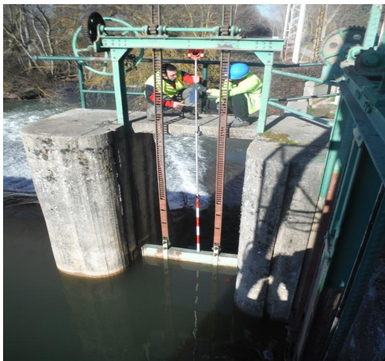
Ilustración 12: Toma de medidas de la compuerta
