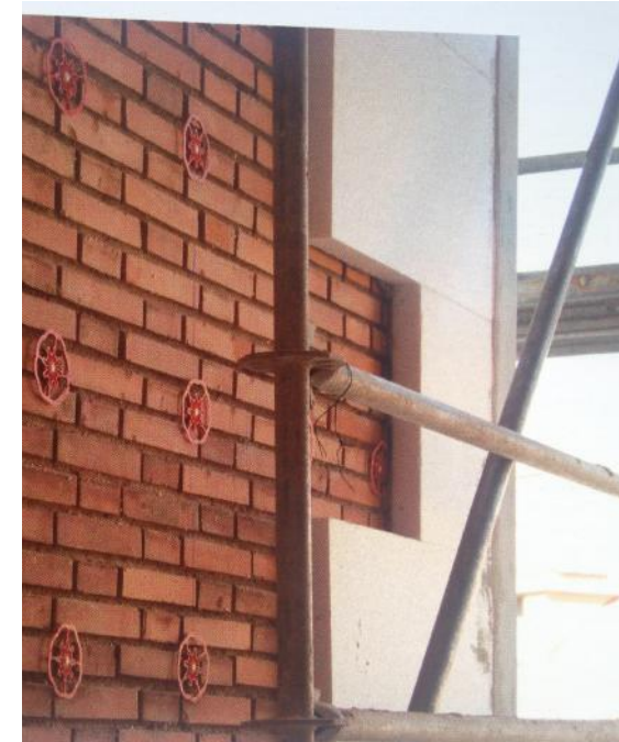
Fig. 32: Fachada: trasdosado del aislamiento. Fuente: VIVA.
