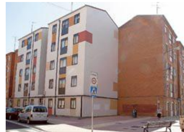
Fig. 7: Regeneración barrio de la Rondilla.
