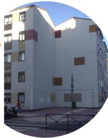
Foto después de la regeneración urbana, donde se ha cambiado la fachada del edificio mejorando su aislamiento su presencia estética, cambiando sus carpinterías. Y también un aumento en la sección de la acera en el punto de cruce.
