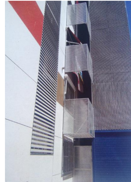
Fig. 34: Núcleo de comunicaciones adosado en las viviendas 18 de Julio. Fuente: VIVA.
