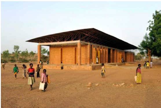
Figura 147: Vista desde el exterior.
