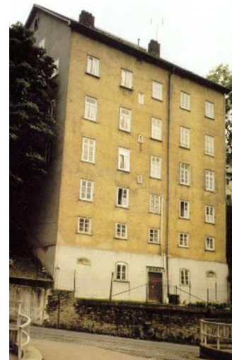
Figura 97: Casa de tapial, Weilburg Alemania, 1828. Un total de cinco pisos de viviendas más bajo cubierta.
