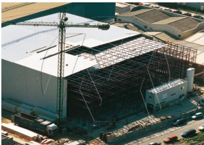
*Figura 4.13- Construcción de un almacén autoportante de grandes dimensiones*
