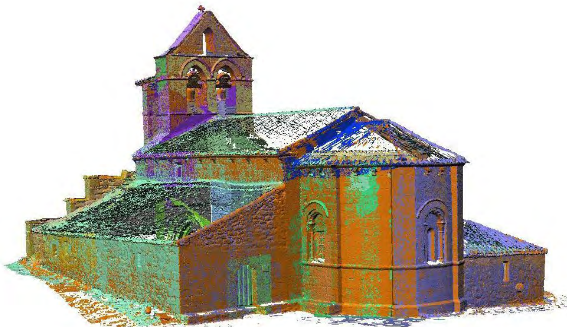
Figura 1-1: Vistas alineadas de la iglesia de Valberzoso (Palencia) adquiridas con un escáner Leica hds3000
