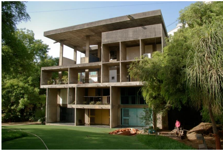
Ilustración 10: Le Corbusier - Villa Shodan (Ahmedabad, 1951)
