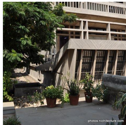
Ilustración 43, 44: Detalles de gárgolas, ventanales del semisótano y brise-soleil en fachada
