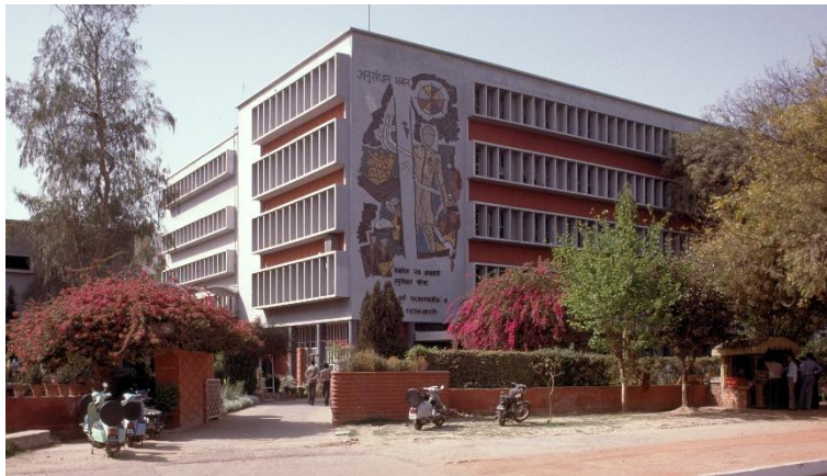
Ilustración 8: A. Kanvinde - Edificio para CSIR (Nueva Delhi, 1956)
