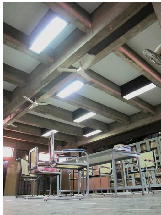
Ilustración 57, 58: Instituto de Indología - Estructura de vigas primarias y secundarias
