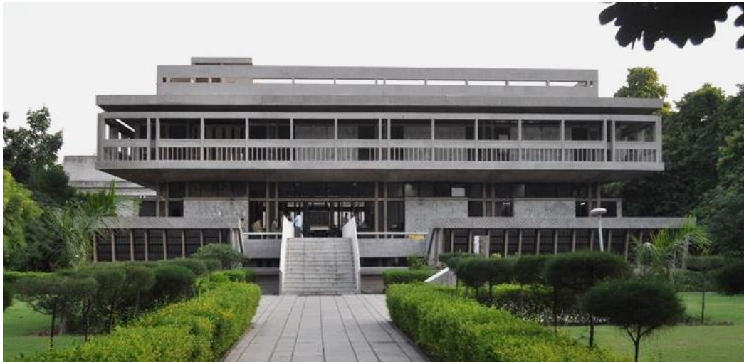
Ilustración 38: Fachada principal (orientación Norte) y entorno
