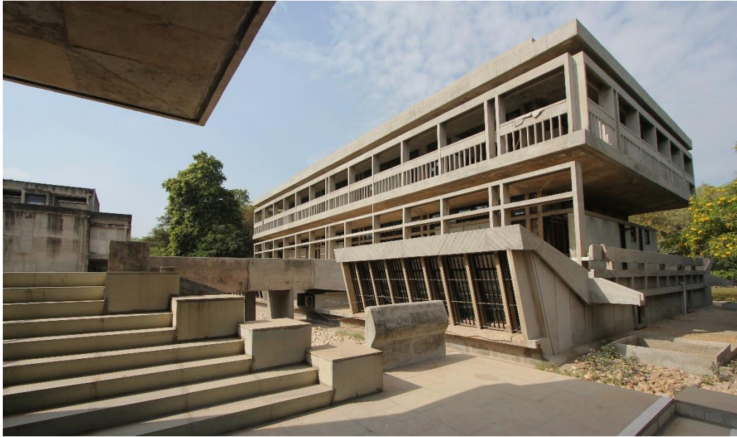
Ilustración 37: Fachada posterior (orientación Sur) y foso empedrado
