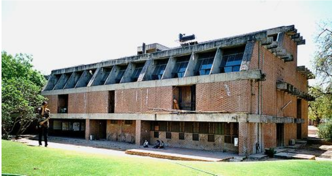
Ilustración 71: Fachada principal (Orientación Norte)
