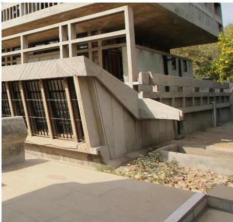
Ilustración 43, 44: Detalles de gárgolas, ventanales del semisótano y brise-soleil en fachada
