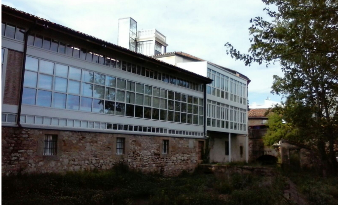
Fig 80. Galerías de la fachada sur. Fuente: Elaboración propia.
