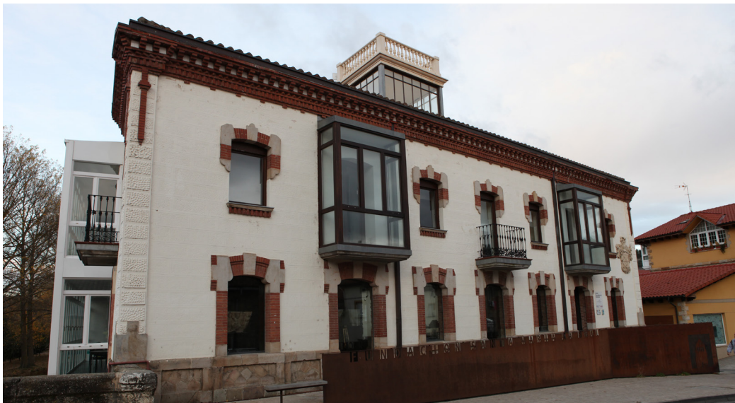
Fig 63. Estado final de la Casa del Puente. Fachada Este. Fuente: Cedita por la Fundación Santa María le Real
