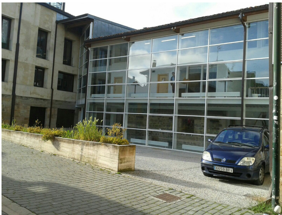
Fig 78. Fachada norte de muro cortina. Fuente: Elaboración propia.
