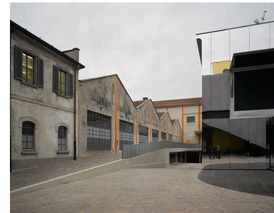
Figura 29: patio. A la derecha el edificio cine. Fotografía de Bas Princen.
