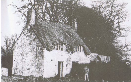
Figura 11: Estado original, con la parte de la derecha ya demolida en parte. Pascua, 1959.
