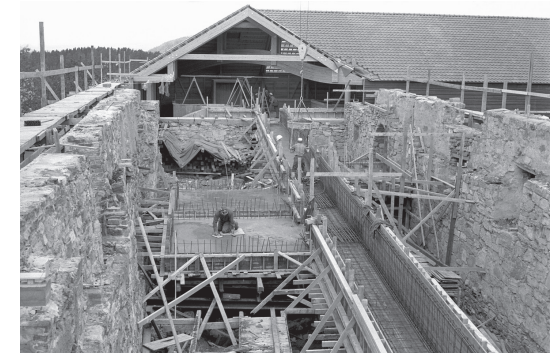
Figura 20: durante las obras de ejecución. Fotografía de Per Martin Tvengsborg.
