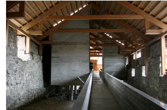
Figura 19: la rampa y las cajas expositivas de hormigón.
