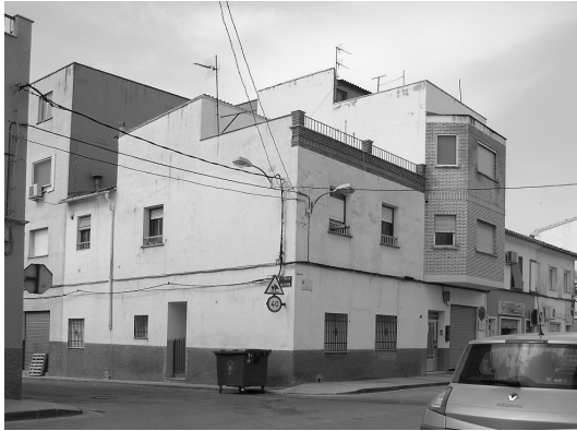
Figura 24: imagen del estado inicial. Fotografía de los arquitectos.
