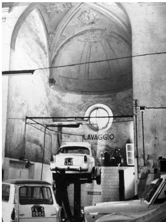
Figura 6: Transformación de iglesia en taller mecánico. Fotografía de Fred Scott en “On Altering Architecture”.
