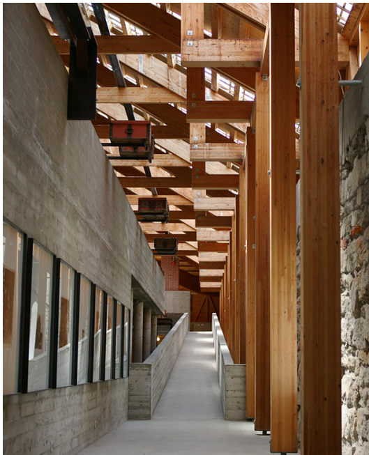
Figura 18: Los soportes de madera de la nueva cubierta. Foto: Peter Guthrie.
