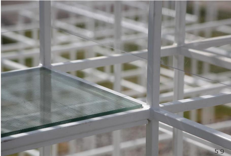
El pabellón consiste en una delicada y sencillísima estructura en tres dimensiones formada por barras de acero de sección rectangular. Siguen un patrón de celosía, dispuesto como un sistema de coordenadas tridimensional. Presenta un módulo base de nudos de acero unidos, de 30 x 30 x 30 cm
