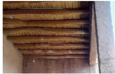
Imagen 62. Vista inferior de cubierta de tierra. Fuente: fotografía propia.
