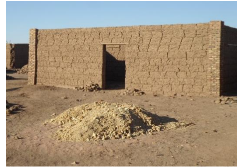
Imagen 60. Muro de tapial. Fuente: Félix Jové Sandoval.
