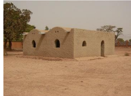
Imagen 15. Cubierta abovedada. Fuente: http://old.lavoutenubienne.org/-La-solucion-tecnica-VN-
