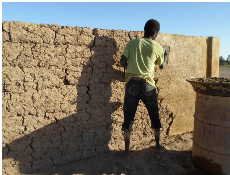
Imagen 50. Recubrimiento del muro de tapia. Fuente: Félix Jové Sandoval.
