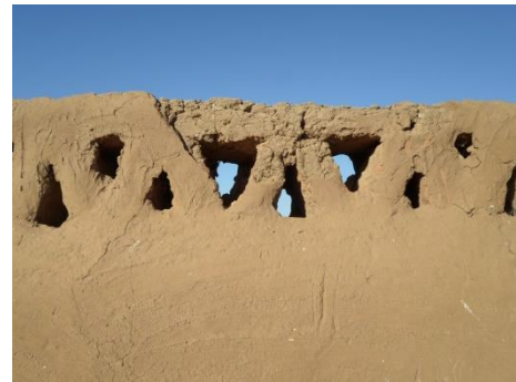
Imagen 65. Remate de muro. Fuente: Félix Jové Sandoval
