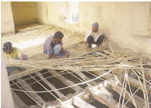
Imagen 54. Colocación del cañizo.
