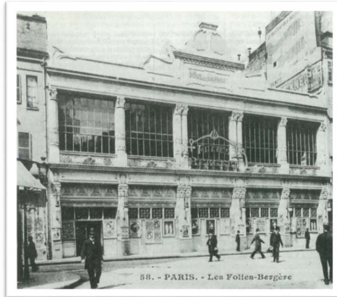
Fachada del Folies Bergère a finales del siglo XIX (Folies Bergère, 2016)
