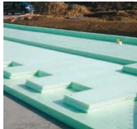
Aislamiento cimentación Styrodur. Fuente: Guía Styrodur
