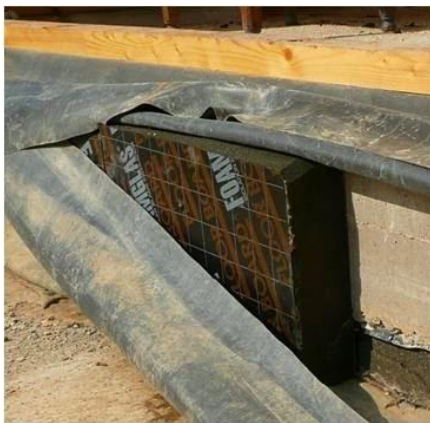
Aislamiento de cimentación FOAMGLAS. Fuente: 3.bp.blogspot.com
