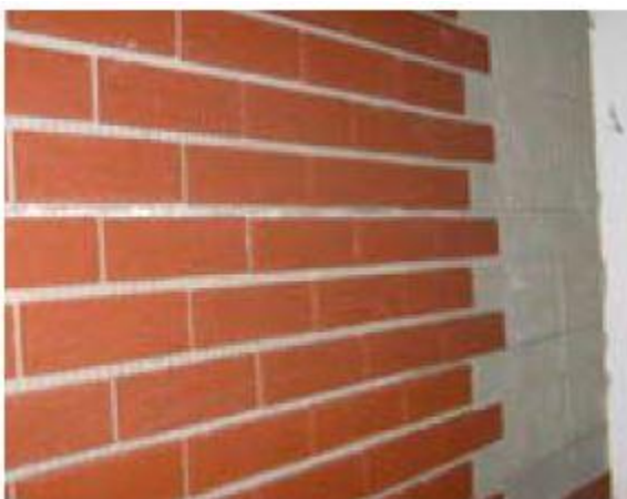
Sate acabado en plaqueta cerámica. Fuente: Guía SATE IDAE
