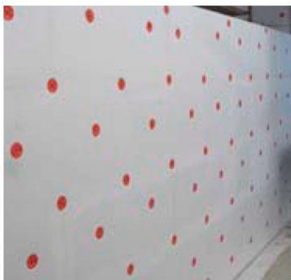
SATE instalado antes del revoque. Fuente: Guía SATE IDAE
