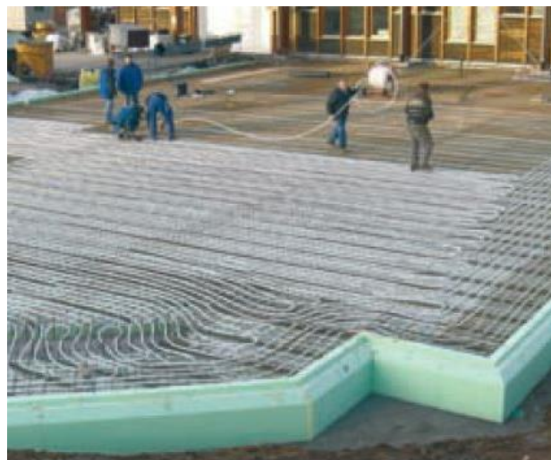
Cimentación aislada y lista para hormigonar. Fuente: Guía Styrodur
