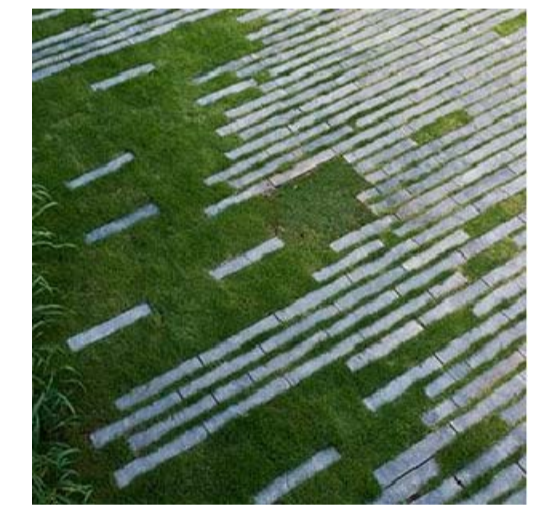
02. Piezas de hormigón prefabricado de alta resistencia EcoGranic, integradas en el terreno que permiten el crecimiento del césped a su alrededor.
