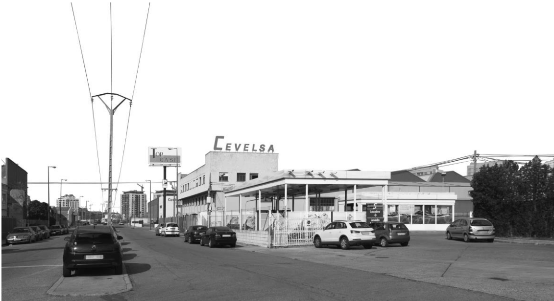
Vista del edificio existente desde la rotonda en la Calle Daniel del Olmo González.
