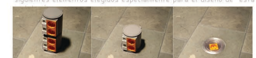
Tarjetas de enchufes de tres tipos del sistema de suelo técnico compacto Matrics, en tres modelos diferentes aplicados en función de las necesidades especiales con 4, 2 o 1 tomas de corriente, las dos primeras incluyen tomas de red.
