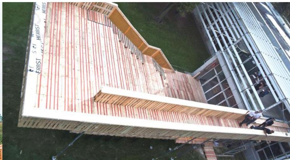
La construcción se ha basado únicamente en la mezcla de elementos de apuntalamiento y andamiaje con palets. Ha sido muy importante crear una estructura estable, capaz de albergar el peso del público. Como cimentación se ha realizado una plataforma de apoyo con perfiles de apeo de encofrado soportado con pilotes metálicos estandarizados que se incan en el terreno.
