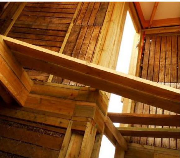
El acabado interior de la vivienda es como el de cualquier casa convencional. Para ello, los palets con los que se han realizado los muros se cubrieron con una malla metálica sobre la que se aplicó una primera capa de mortero de barro, para acabarse con mortero de yeso más fino, sobre la que se puede pintar o pegar papel pintado.
