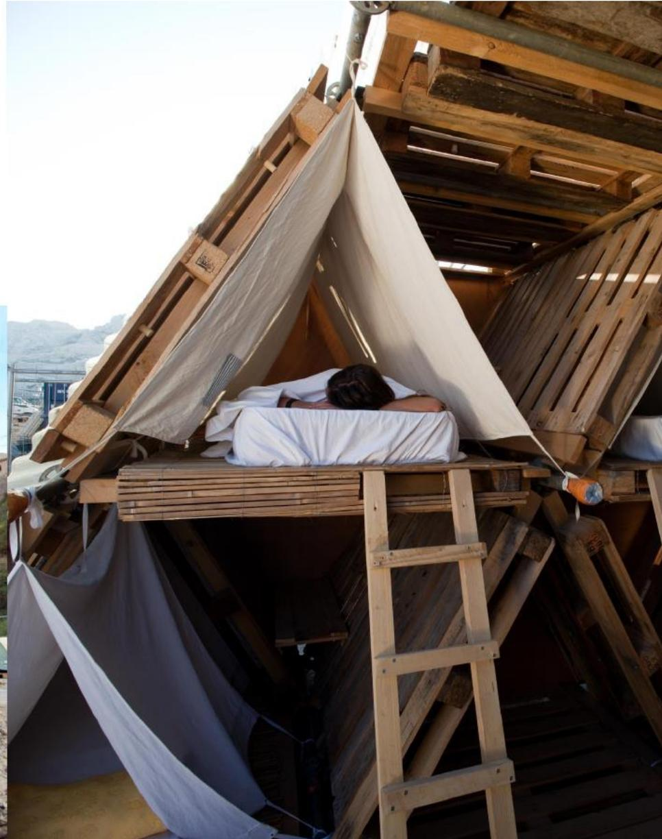
**Construcción** - El diseño hace uso de componentes de andamios de acero como elementos estructurales de carácter portante, los palets de madera tienen función de soporte de carga de relleno y plataformas de madera como revestimiento.
