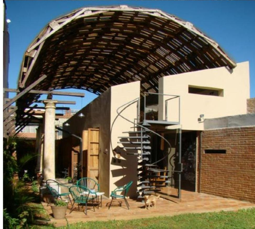
Para el trazado de la expresiva cubierta curva se utilizaron cimbras metálicas ligeras que después construida se eliminaron. La bóveda se apoya longitudinalmente en sus dos bordes: uno constituido por una viga canalón de hormigón armado, y otro por un perfil metálico apoyado en columnas de piedra y puntales de madera reutilizados.
