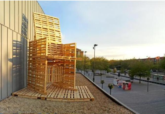
La segunda parte, consistió en la realización de mobiliario a gran escala, con palets americanos (100 uds), unidos mediante el mismo sistema que las anteriores construcciones. Se han creado sillas y mesas ubicadas en la cafetería de la sala, y una silla de escala gigante situada en la cubierta del edificio, con el fin de actuar como reclamo para la exposición interior.
