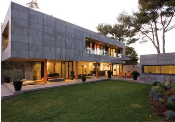
Viroc es un panel de madera y cemento. Un material composite, formado por una mezcla de partículas de madera y cemento comprimido y seco.
