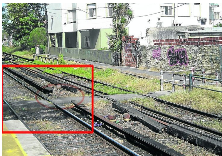
Fig. 2.2.4 Interrupción tercer riel por paso a nivel
