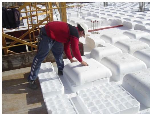
Img. 43. Operario colocando piezas de EPS para forjado
