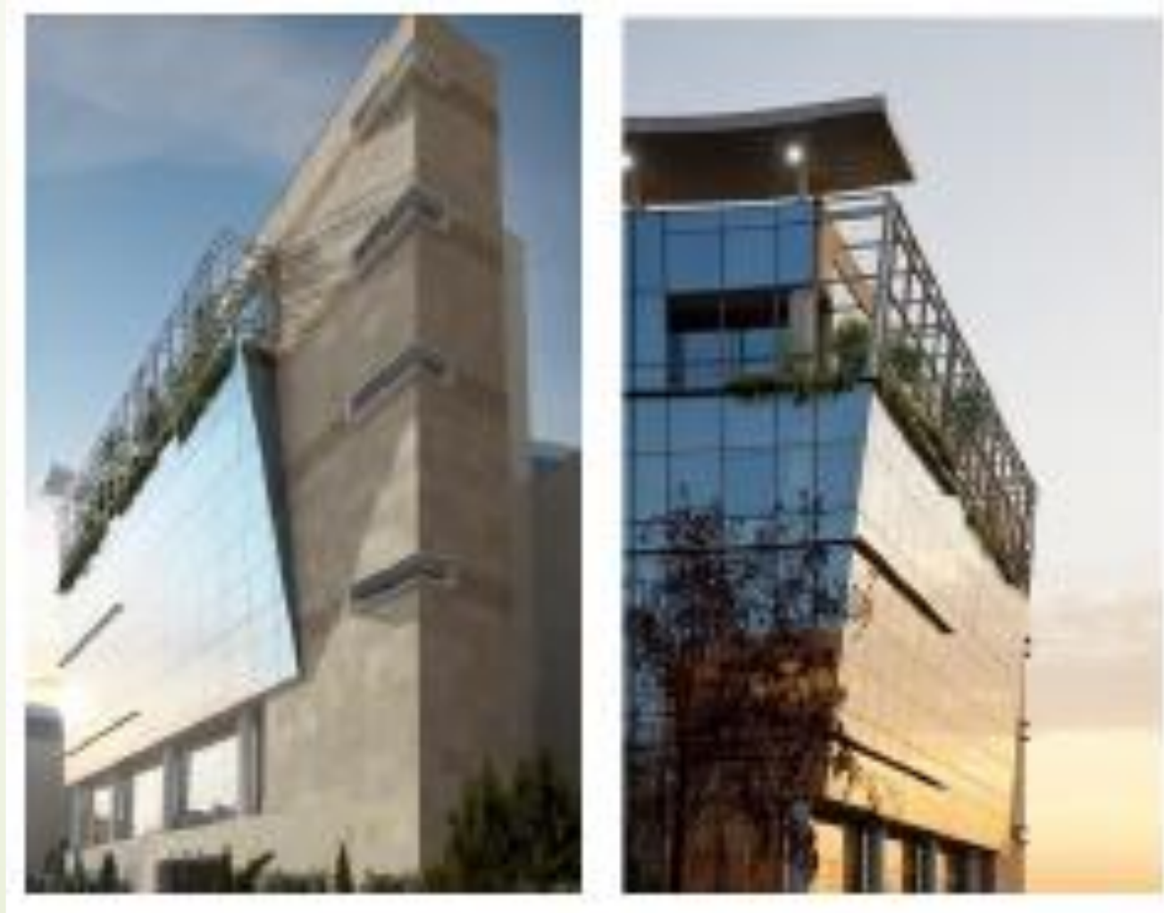
Fachada ABC Cáncer Center – Ciudad del México
