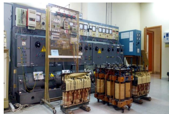
Figura 19B. Fotografía del montaje del ensayo con carga inductiva. [9]
