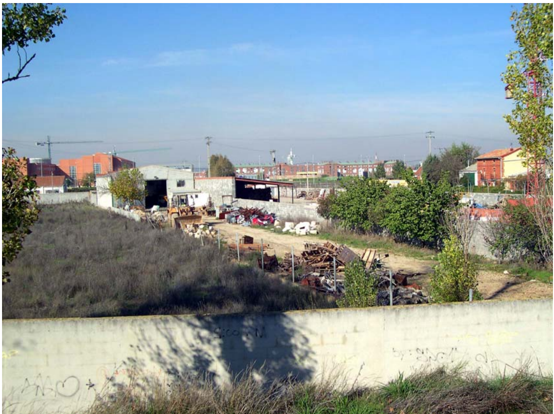
9.- Viejas naves industriales y almacenes en el Camino de Palomares
