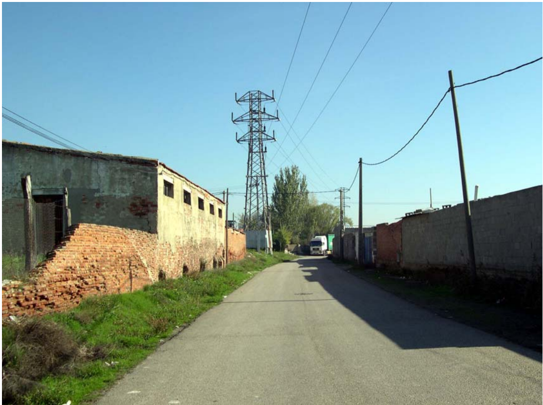
13.- En el límite de la degradación urbana. Tapias de viejas fábricas e infravivienda en el tramo final del camino viejo de Renedo
