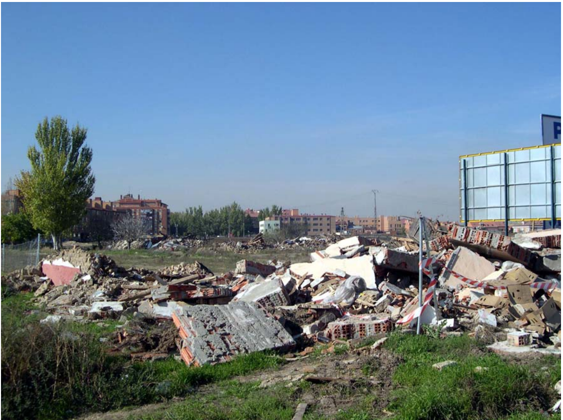
3.- Un borde urbano necesitado de urgente reforma . Vista de los solares de la futura intervención. Los Santos Pilarica.
