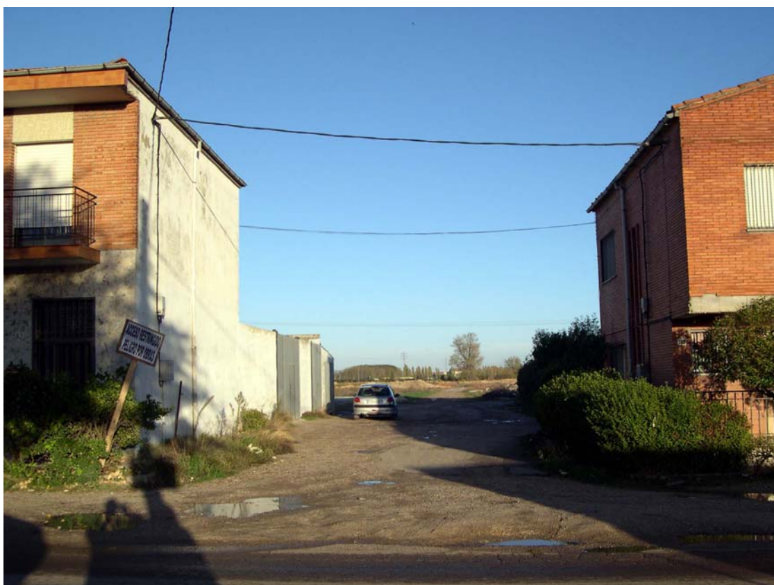
1.- Viviendas abandonadas en el tramo norte –final- del Paseo de Juan Carlos Primero. Una muestra del abandono del sector antes del inicio de la urbanización del sector 16: Los Santos.
