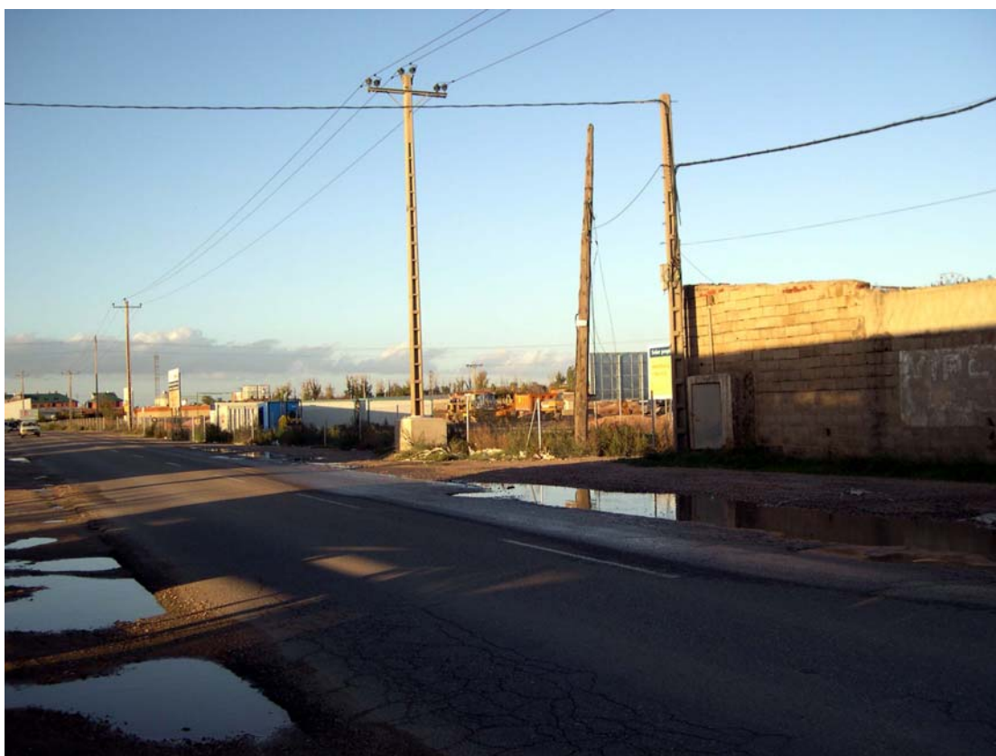
2.- Vista sur -dirección Pilarica- del Paseo de Juan Carlos Primero . Chamizos industriales semiabandonados en un tramo del paseo sin encintado de aceras y con las infraestructuras en el límite de la legalidad. Sector 16: Los Santos.
