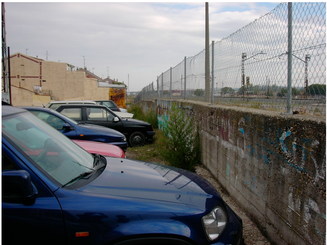
6- Vistas del pasillo ferroviario frente al futuro Centro Comercial. Una muestra de la extrema degradación paisajística del este-norte de la ciudad
