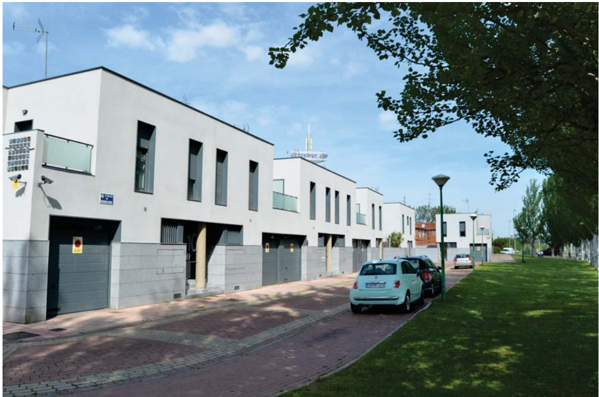
Figura 46: Viviendas rehabilitadas en el Parque de la Ronda. Imagen propia 2016
