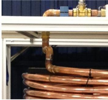
*Figura 4.14 Conexión serpentín-tubería llaves*
