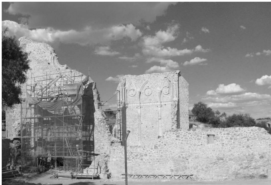
Fig. 3. Vista de la iglesia desde los pies. Fotografía de la autora.
