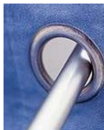
Figura 64: detalle del enganche de la tela con la estructura.
