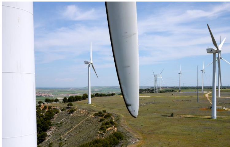
Figura 51, daño producido por erosión de partículas sobre una pala y una torre de un aerogenerador.
