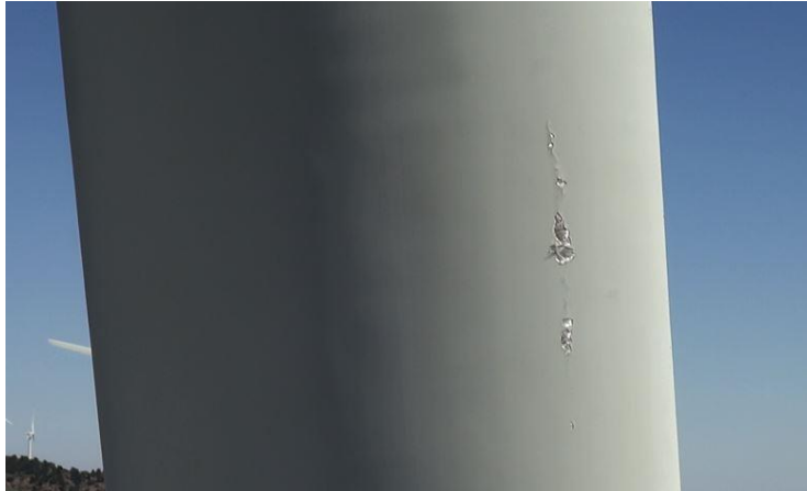
Figura 50, daño producido por un impacto sobre una pala de un aerogenerador.
