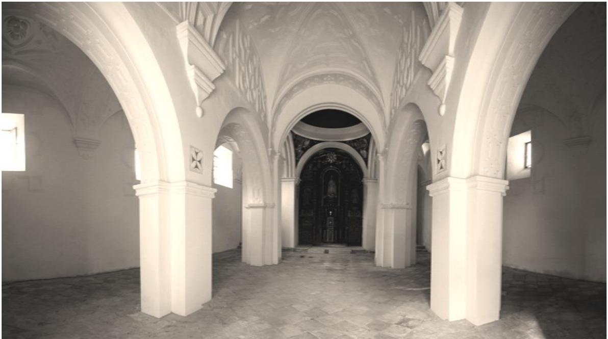
**BÓVEDAS BARROCAS EN LAS NAVES.** La obra del las bóvedas de las naves obligó a recrecer los muros laterales, igualando los faldones de la nave central con los de las naves laterales. Las bóvedas tabicadas, de arista en la central y de lunetos en las laterales, se construyeron directamente sobre las fábricas románicas.
