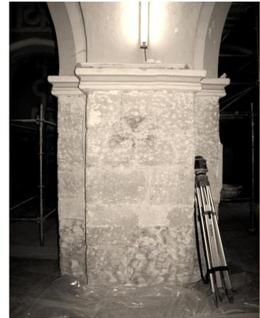
**ARCOS FORMEROS.** Se conservan íntegros los arcos formeros que separan las naves. Sobre pilastras dobladas de sillería de arenisca local, en forma de cruz la sur y más alargada la norte, se apoyan impostas de bocel y nacela y de filetes junto a las capillas. Los arcos son doblados lisos de medio punto. Se conservan restos de aguadas de cal y varias cruces de consagración pintadas en tonos rojos sobre fondo blanco.
