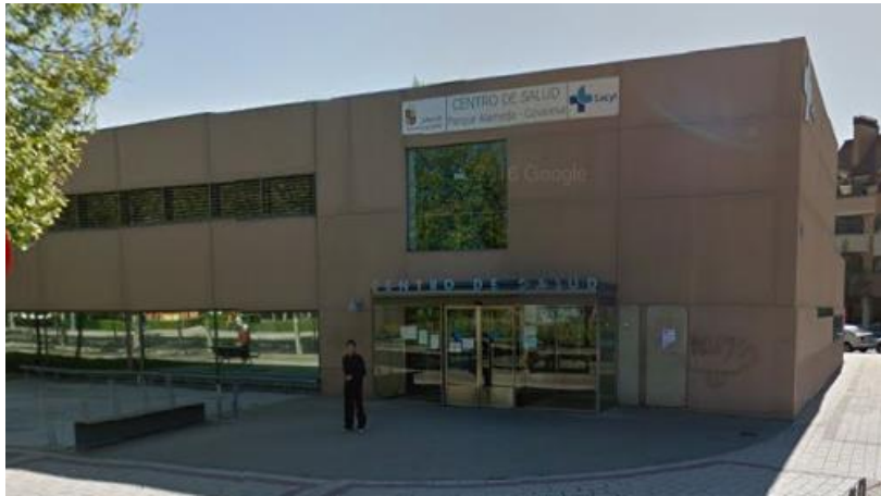
Figura 2.11. Centro de Salud Parque Alameda Covaresa.
