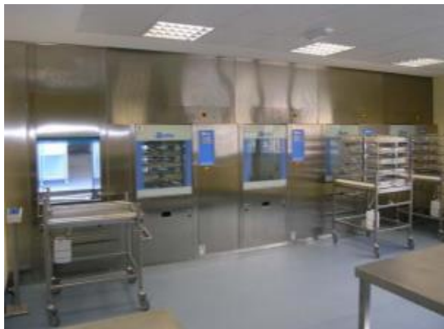
Figura 3.8. Zona de lavado y desinfección automatizada, visto desde la zona de lavado de la UCE. (Ministerio de Sanidad, Política social e igualdad, 2011).
