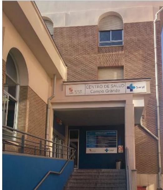
Figura 2.7. Centro de Salud Casa del Barco.
