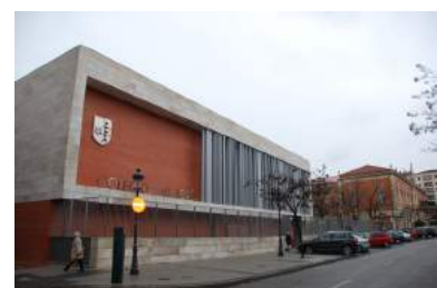
[Arriba] Imagen del Colegio El Salvador, aun sin reutilizar. [Abajo] Parcela del Colegio La Salle tras la reforma del patio, incluyendo un nuevo módulo y aparcamiento.
