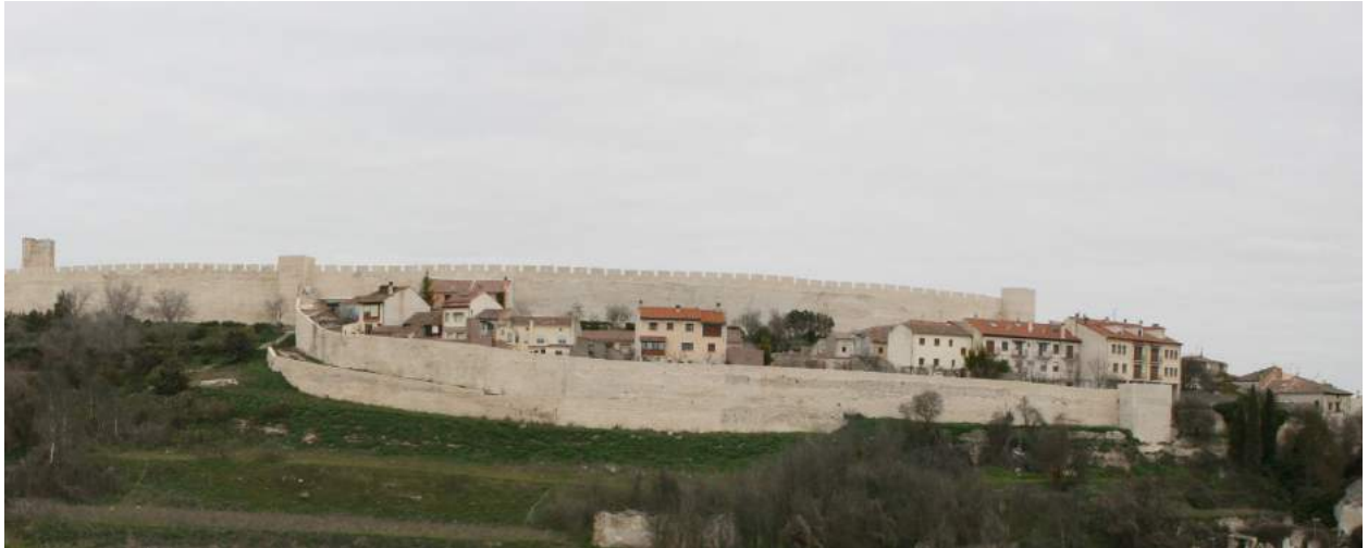
Vista del Conjunto Histórico de Cuéllar y su doble recinto amurallado
