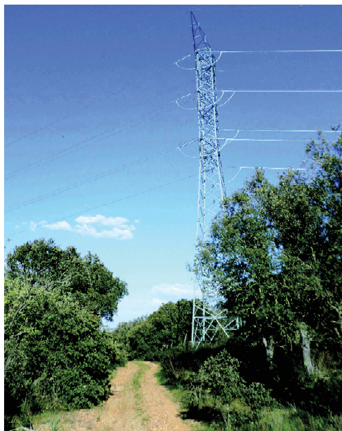
Imagen 4: Tendido eléctrico cercano a la pista.
