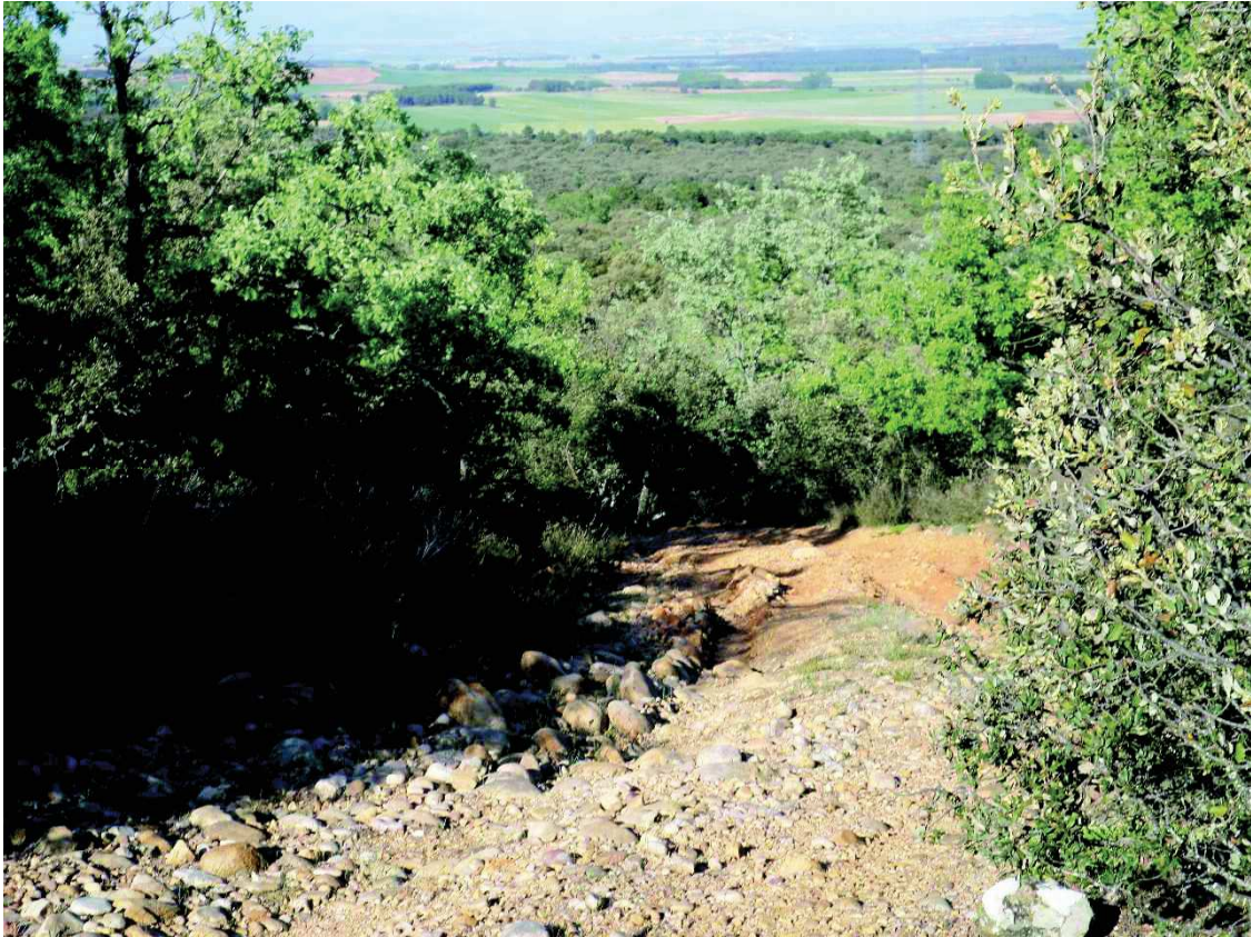
Imagen 7: Elevada pendiente del trazado actual y estado de deterioro.
