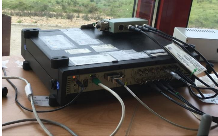
Figura 8. Frontend situado en el interior de la sala del Centro Municipal de Acústica.
