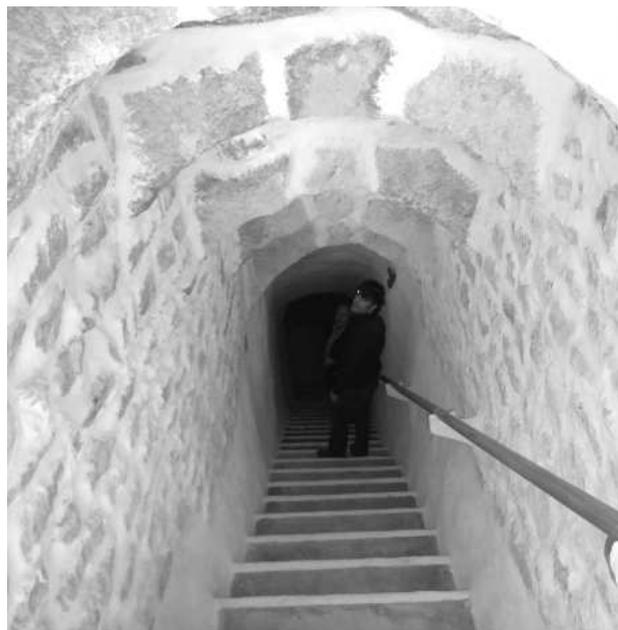
Generalmente el techo de los cañones se conforma mediante dos sistemas constructivos, la bóveda de piedra y las vigas (latas) de madera de enebro, este último sistema es menos habitual que el primero. Algunos cañones de bajada a las bodegas combinan estos dos sistemas constructivos, y la longitud de uno u otro viene dada por la disposición del cañón de bajada respecto al frente de fachada de la bodega y a la pendiente del terreno.
