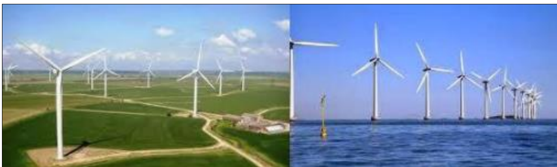
Figura 2.3. Parque eólico Onshore y Offshore. Fuente: http://www.green-mechanic.com
