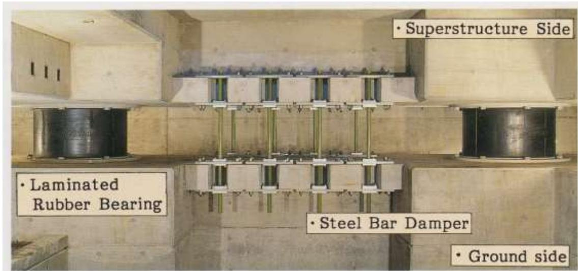
**Figura 1.3.** Sistema de aislamiento sísmico (fuente:<http://civildigital.com/wp-content/uploads/2016/03/Elastomeric-Rubber-Bearings-1024x486.jpg>)
