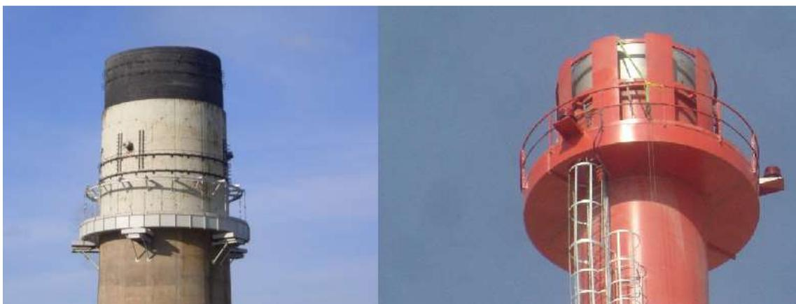
**Figura 1.4.** TMD y TLD en chimeneas (fuentes: <http://www.multitech-fr.com/images/dampers/0001a1.JPG> y <http://www.multitech-fr.com/images/dampers/0002DSC07935.jpg>)
