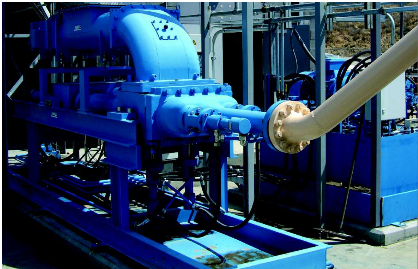
ABEL SH con doble alimentador de tornillo y carga superior para el transporte de lodos de depuradora deshidratados
