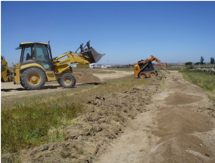
Figura 6. Maquinaria de obras públicas en el proyecto de Consolidación de la Calzada de la Fuenfría (Segovia)
