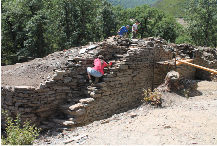
Figura 4. Trabajo de cantería en la consolidación de la muralla del Castro de La Muela (Laciana, León)
