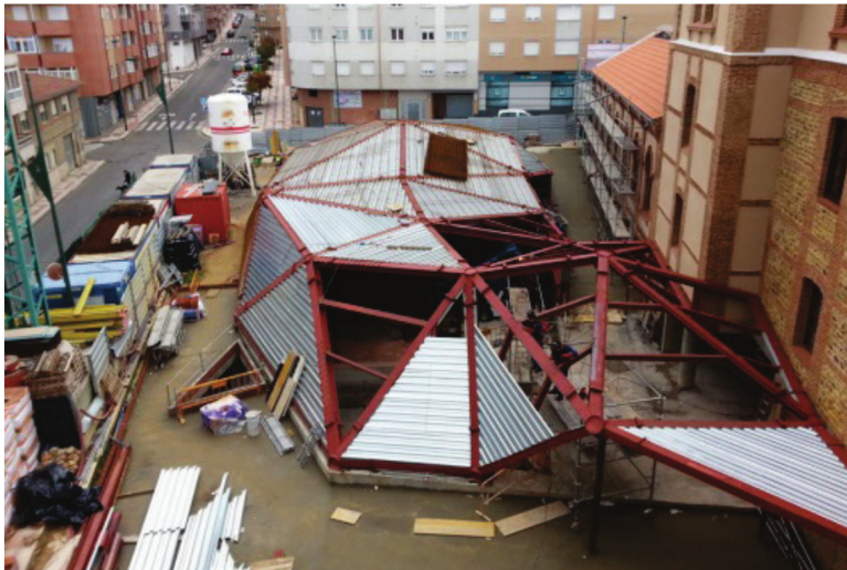
Figura 10: Edificios rehabilitados y obras en la fábrica Araú
