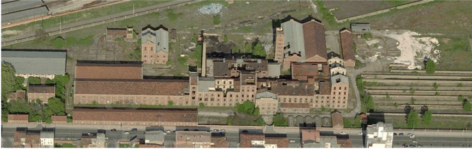
Figura 7: Aspecto original de la azucarera y resultado de la intervención
