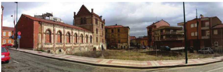
Figura 9: Estado original de la fábrica abandonada y alzado del proyecto de rehabilitación aprobado en 2007
