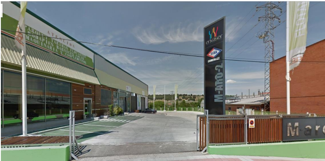
Figura 1. Vista de las instalaciones de EISA
