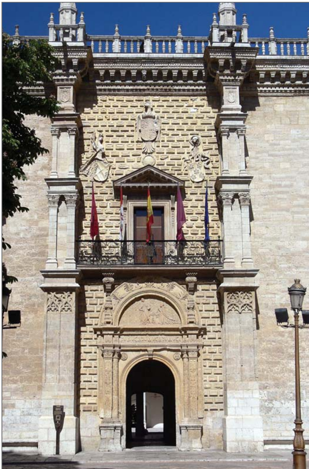
Fig.10. Visión general de la portada principal del Colegio de Santa Cruz en Valladolid.
