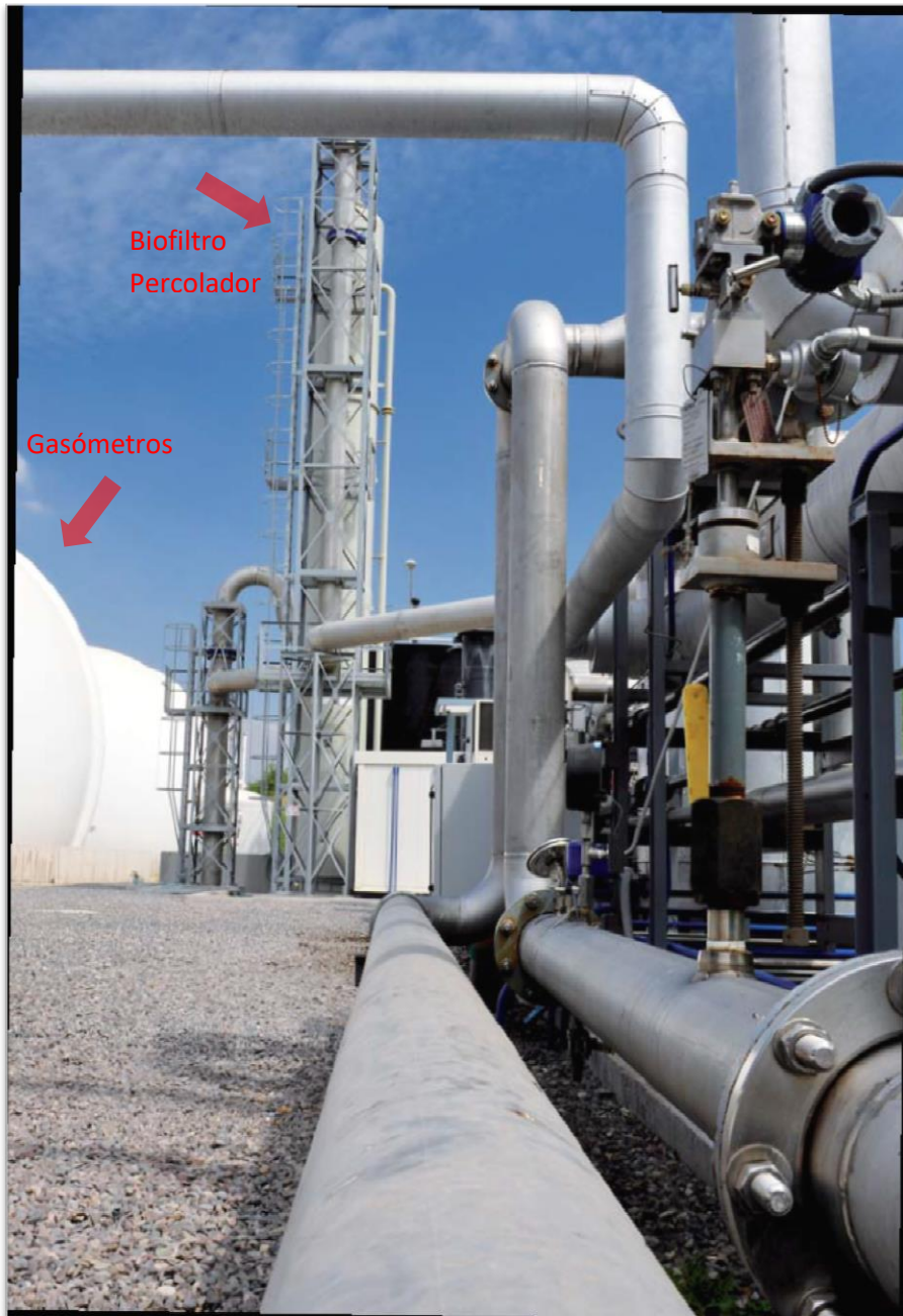
Figura 2. Planta piloto de un biofiltro percolador empleado en la desulfuración del biogás (Universidad de Cádiz, García y col. 2016).
