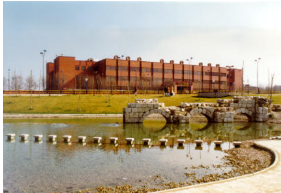
Figura 115. Fotografía de la sede Paseo del Cauce.
