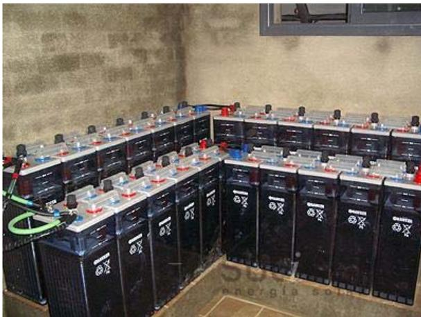
Figura 1.11. Fotografía de un grupo de baterías de una instalación fotovoltaica aislada.
